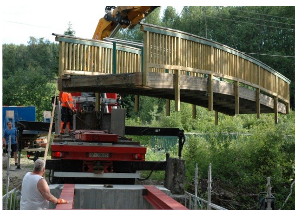
Takket være at Bjonerøingene mye god kompetanse og tilgang til forskjellig maskiner og utstyr, kunne en relativt komplisert prosess løses med lokale krefter. Brua heises på plass i Stilla Elvepark, juli 2010.
