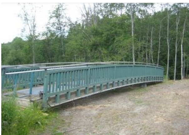
Denne brua, som har en historie fra Aker Brygge i Oslo, har fått et nytt liv i Bjonerøa. Tilfeldigheter og flaks har blitt en god historie.
